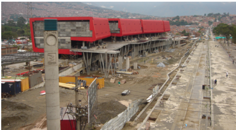
Obras en la carrera Carabobo y construcción del Parque Explora, el parque de ciencia y tecnología de Medellín (2007).
