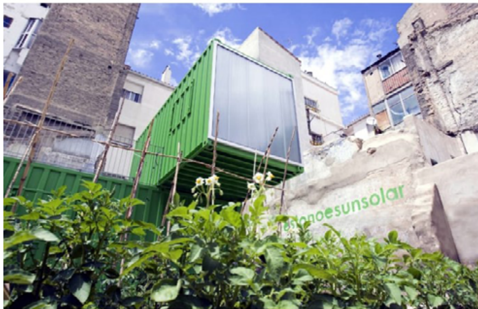
“Estonoesunsolar”, en la calle Armas del Barrio de San Pablo, Zaragoza.
