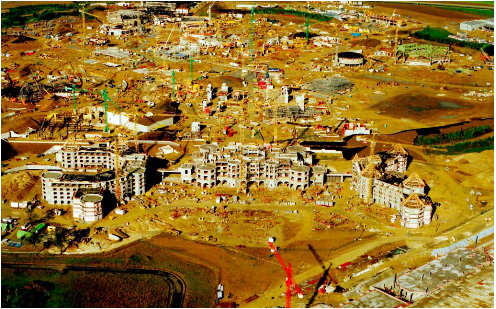
Disneyland París en construcción a mediados de la década de 1980, como parte de un proceso de desarrollo a gran escala y a largo plazo de la nueva ciudad de París, Marne la Vallée, incluyendo la construcción de una estación de tren de alta velocidad TGV, un gran centro comercial, oficinas, viviendas e infraestructura social ( https://disneylandparis-news.com/disneyland_paris/histoire/ ).
